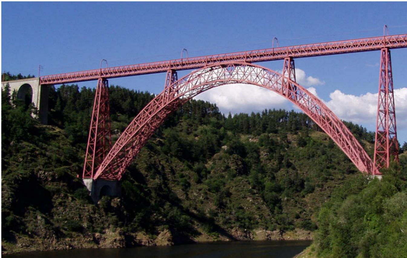
Le viaduc de Garabit est un pont en arc de parabole...
