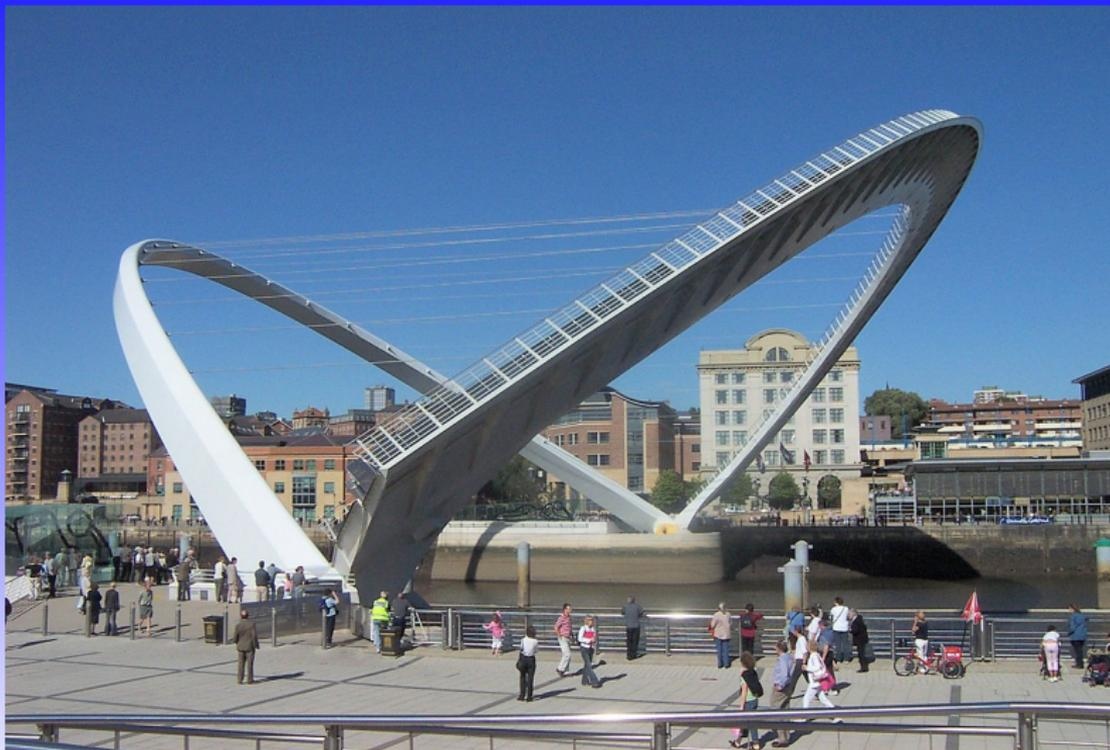
Gateshead Millennium Bridge, pont piétonnier rotatif à Gateshead.
